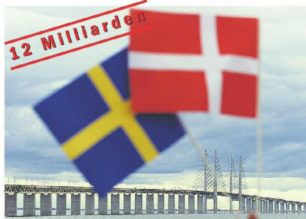
Bau der Öresund-Brücke zwischen Dänemark und Schweden.
